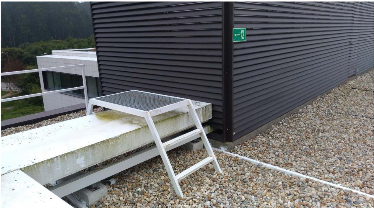
Figura 10. Detalle obstáculo formado por canalizaciones y medidas provisionales de paso
