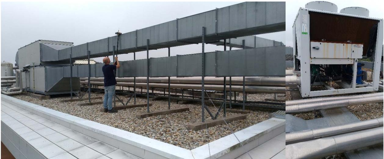
Figura 14. Imagen en la que se observan las interferencias producidas por las instalaciones de servicio en cubierta.
