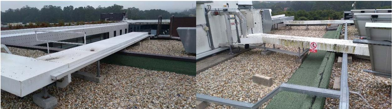
Figura 6. Imagen en la que se observan las interferencias producidas por las instalaciones de servicio en cubierta.
