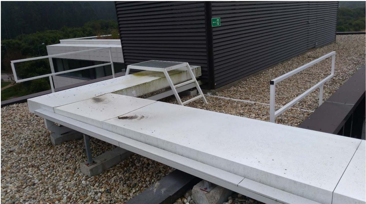
Figura 9. Obstáculo formado por canalizaciones y medidas provisionales de paso
