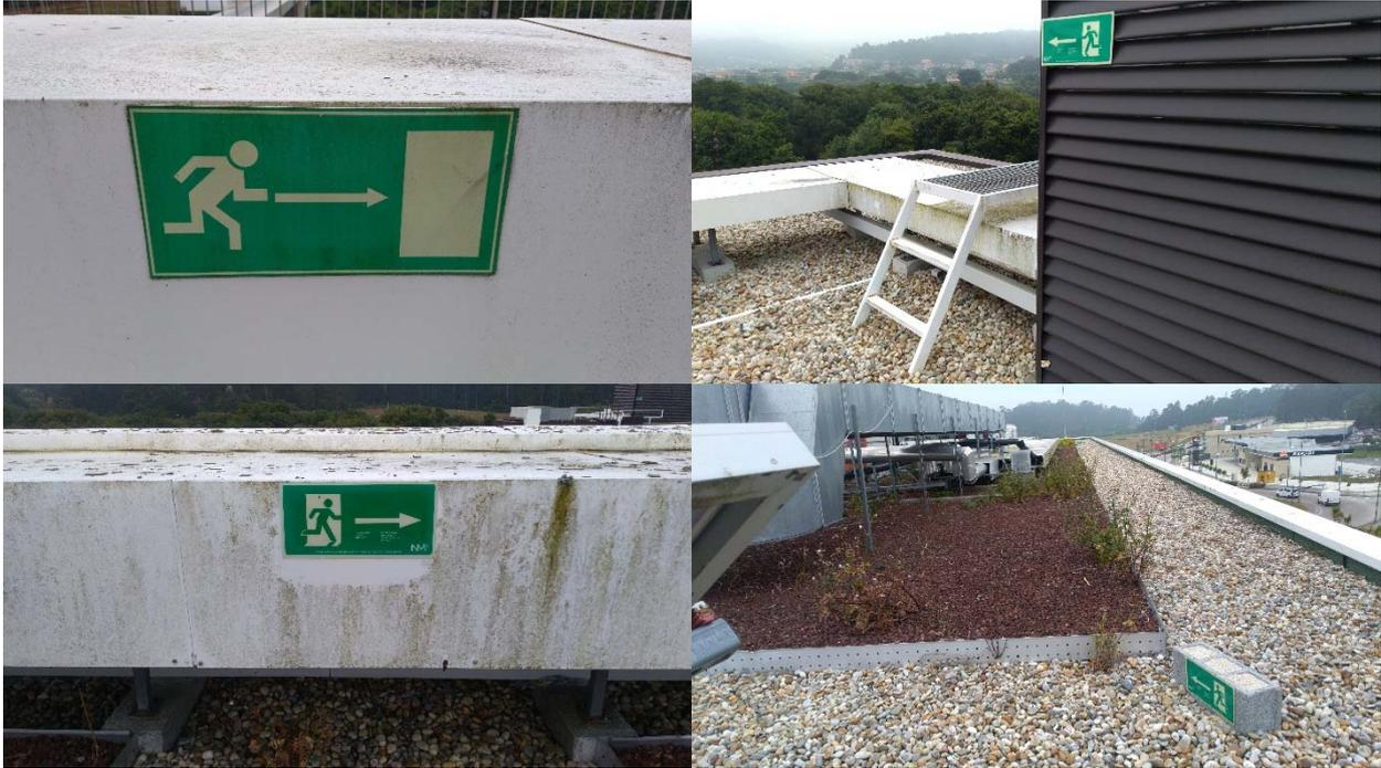
Figura 8. Señalización de evacuación en cubierta
