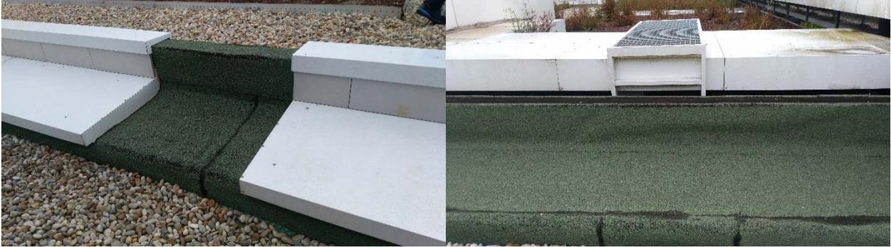
Figura 5. Imagen en la que se observan los desniveles producidos por los diferentes volúmenes existentes en la cubierta
