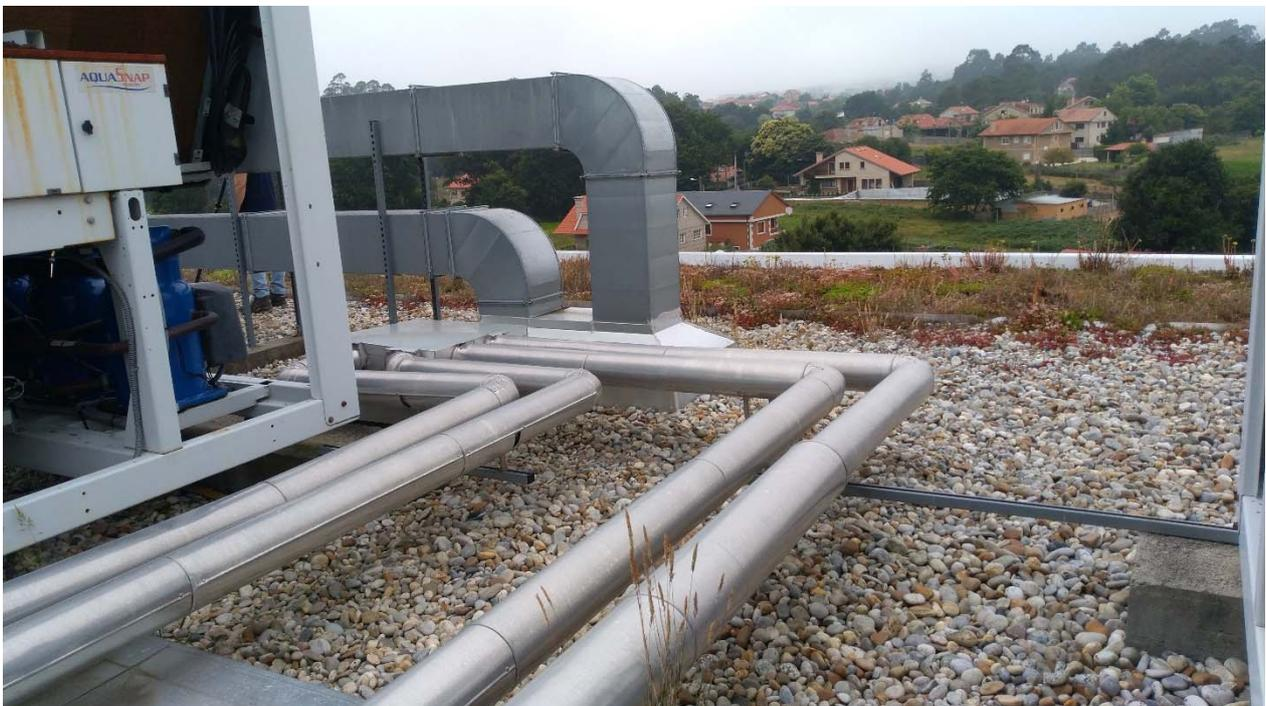
Figura 28. Detalle canalizaciones en cubierta que impiden acceso habilitado a maquinaria
