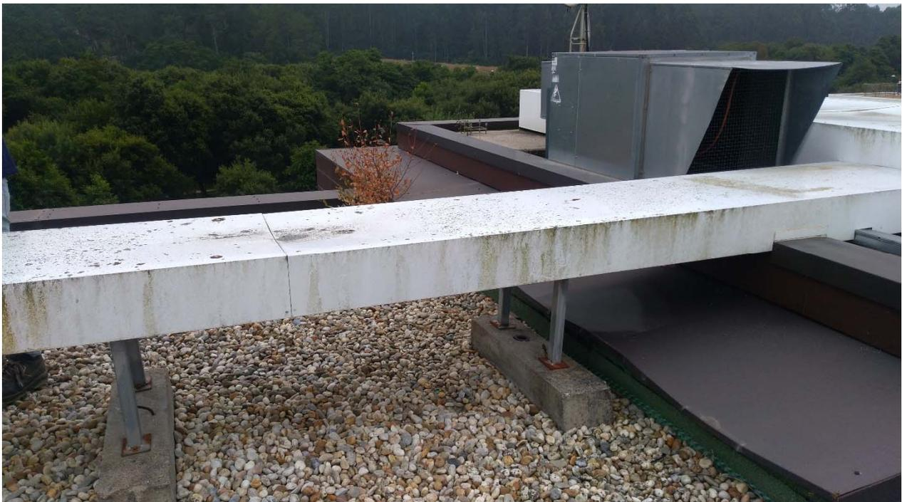
Figura 18. Obstáculo para acceso a antena en cubierta
