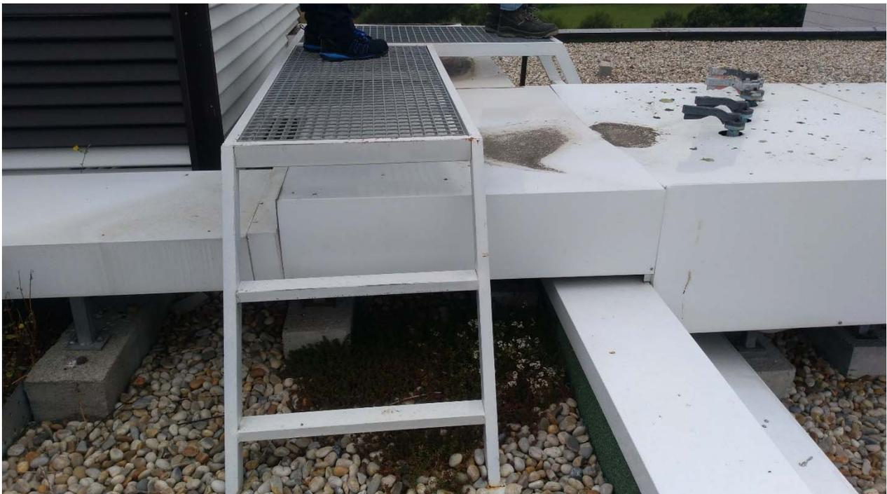
Figura 12. Detalle obstáculos por canalizaciones en cubierta
