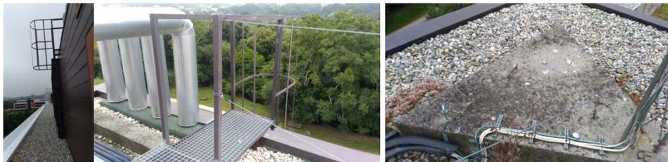
2. Escala edificio ETA, protección en el desembarco y punto de anclaje.
