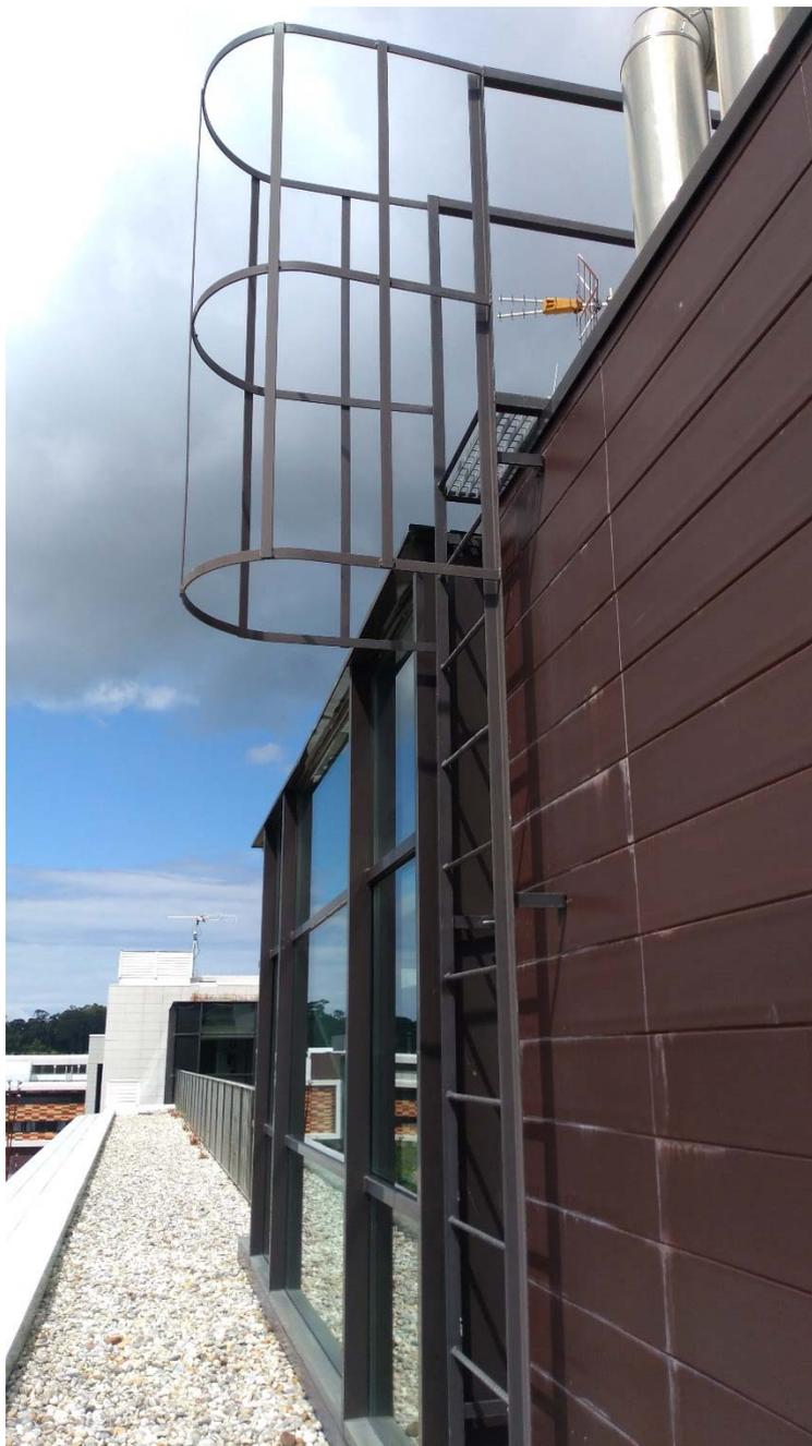
Figura 20. Escada de acceso a nivel superior cubierta
